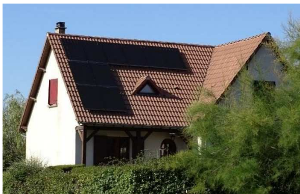
Figure 71 - Installation individuelle de panneaux solaires- photovoltaïques à Flogny La Chapelle
