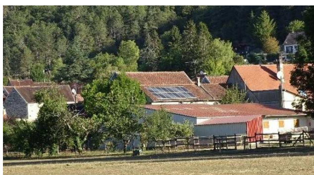
Figure 73 - Installations individuelles de panneaux solaires – photovoltaïques à Saint-Martin-Sur-Armançon
