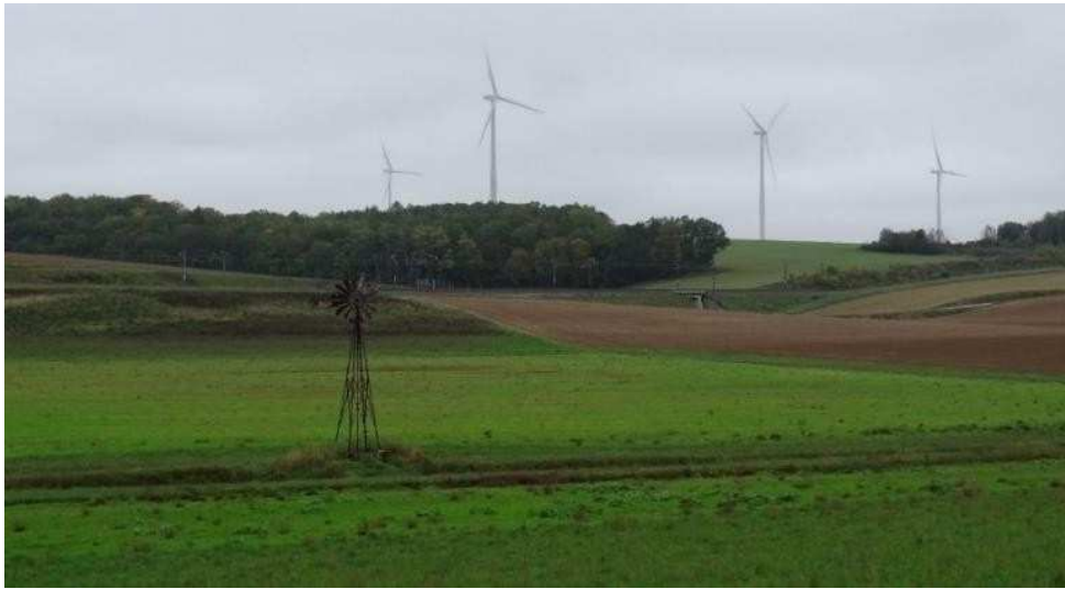
Figure 70 - Eoliennes de Dyé depuis Vézannes, 2 AD
