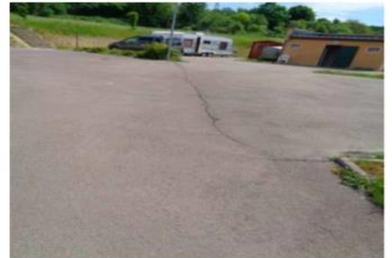
Reprise de la fissure (scellement de fissure)
