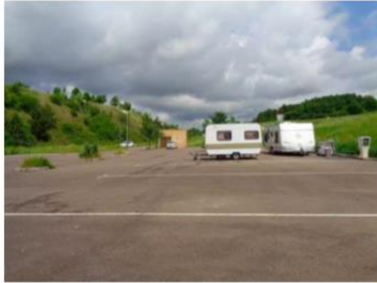
Bon état général de la chaussée
