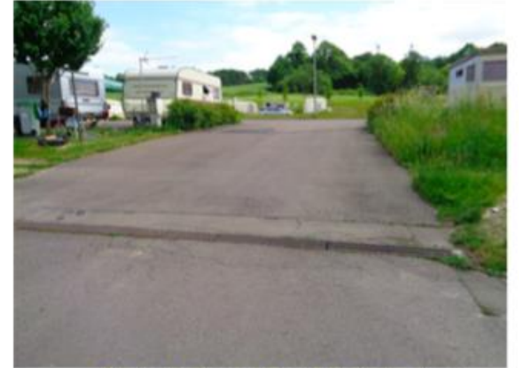
Reprise de la chaussée de part et d'autre du caniveau
